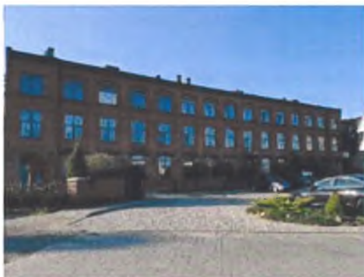
Zdjęcie 50. Budynek o bardzo dobrym stanie technicznym stolarki okiennej i drzwiowej przy ul. Nowy Świat 8.
