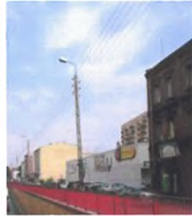
Zdjęcie 50. Latarnia uliczna jednoramienna, ul. 1 Maja Źródło: Opracowanie własne, październik 2018
