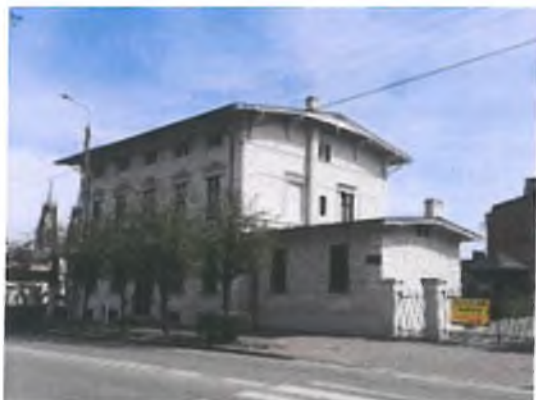
Zdjęcie 45. Budynek o bardzo dobrym stanie technicznym dachu przy ul. Limanowskiego 41.
