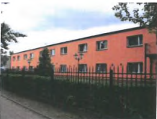
Zdjęcie 31. Budynek powstały w okresie 1940-1989 r. przy ul. 1 Maja 63a.
