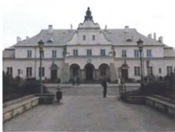
Zdjęcie 20. Nawierzchnia na placu przed Dworcem PKP Źródło: Opracowanie własne, październik 2018
