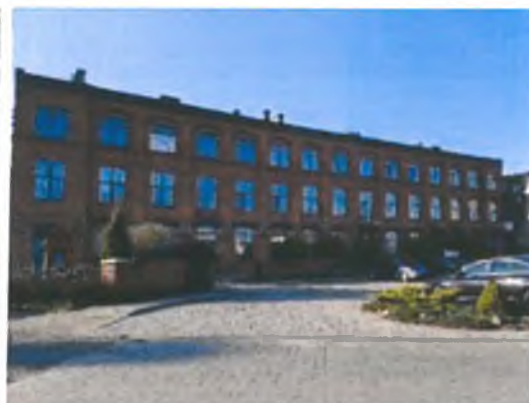
Zdjęcie 61. Budynek o bardzo dobrym stanie technicznym fundamentów przy ul. Nowy Świat 8.
