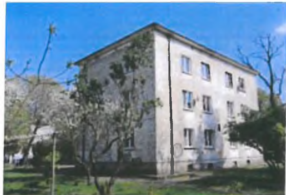
Zdjęcie 22. Zabudowa o 3 kondygnacjach. Budynek przy ul. Mireckiego 60/7
