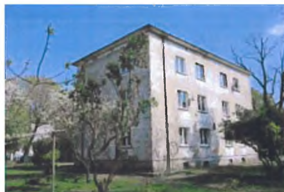
Zdjęcie 5. Zabudowa wolnostojąca – budynek przy ul. Mireckiego 60/7
