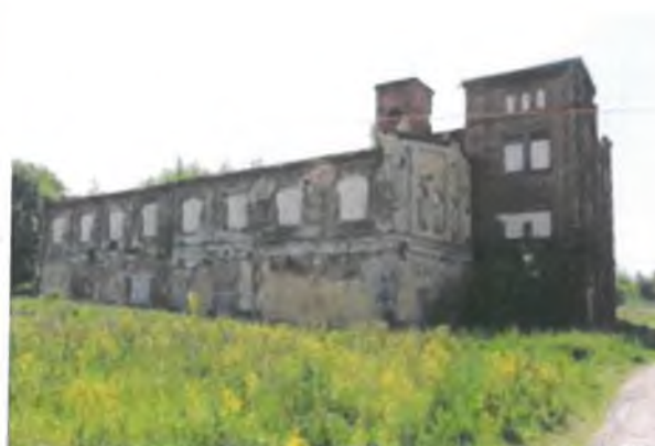
Zdjęcie 57. Obiekt w stanie katastrofalnym przy ul. Dittricha 10j.
