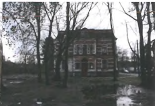
Zdjęcie 4. Zaniedbana przestrzeń publiczna
