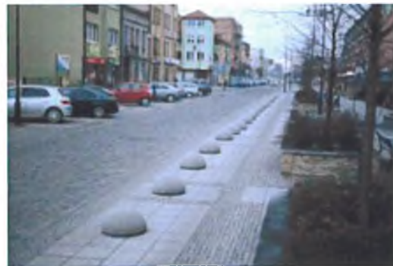
Zdjęcie 47. Betonowe „grzybki” na ul. Okrzei
