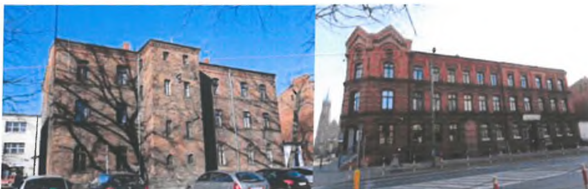
Zdjęcie 63. Przykłady budynków, w których stan zachowania historycznej stolarki okiennej został określony jako dobry lub bardzo dobry
