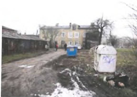
Zdjęcie 3. Zaniedbana przestrzeń publiczna
