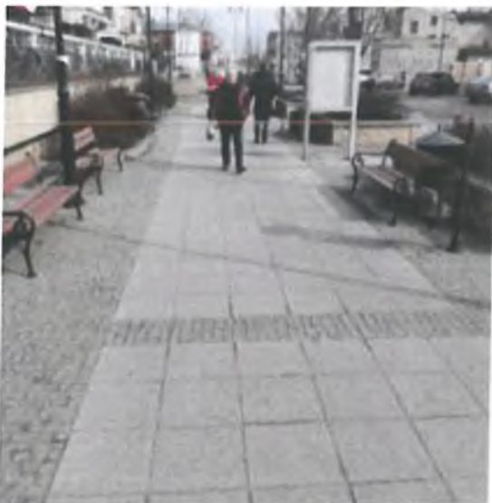
Zdjęcie 107. Zmodernizowana nawierzchnia w ulicy Okrzei
