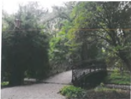
Zdjęcie 55. Mostek w Parku Dittricha (bardzo dobry stan zieleni)
