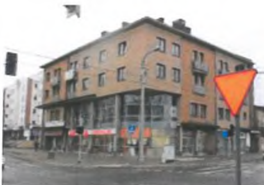
Zdjęcie 39. Bardzo dobry stan elewacji – budynek przy al. Partyzantów 15
