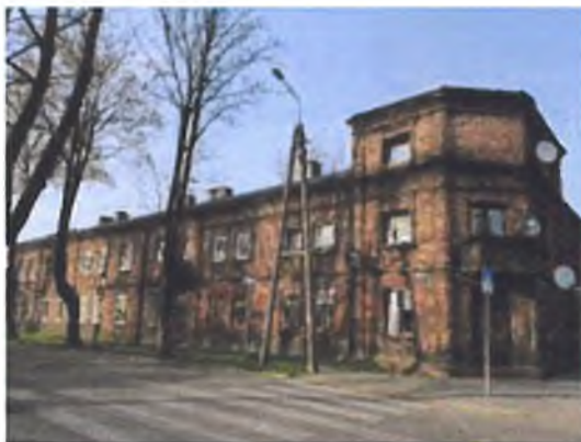
Zdjęcie 48. Budynek o średnim stanie technicznym stolarki okiennej i drzwiowej przy ul. Waryńskiego 28-30.
