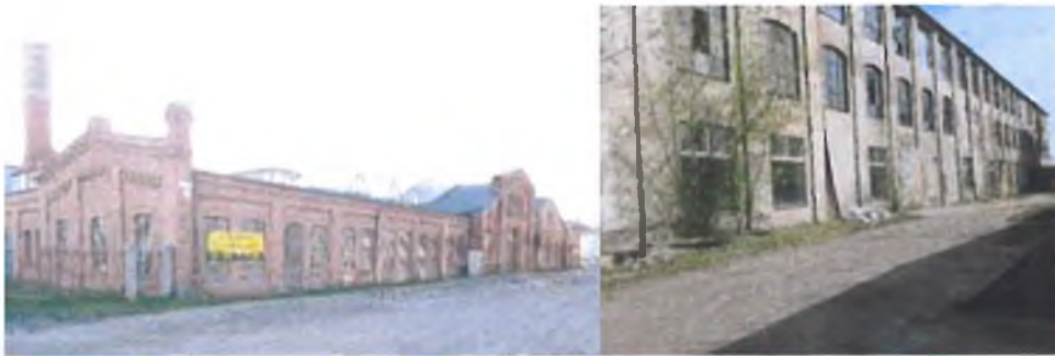
Zdjęcie 52. Nieużytkowane obiekty na dawnym terenie przemysłowym Centrali
