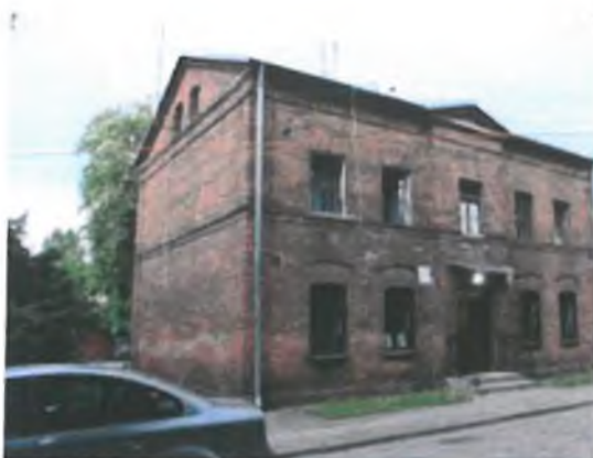
Zdjęcie 58. Budynek o dobrym stanie technicznym fundamentów przy ul. Żeromskiego 2
