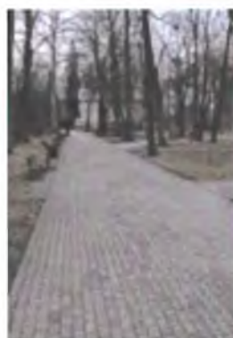
Zdjęcie 27. Nawierzchnia z kostki betonowej - stan dobry
