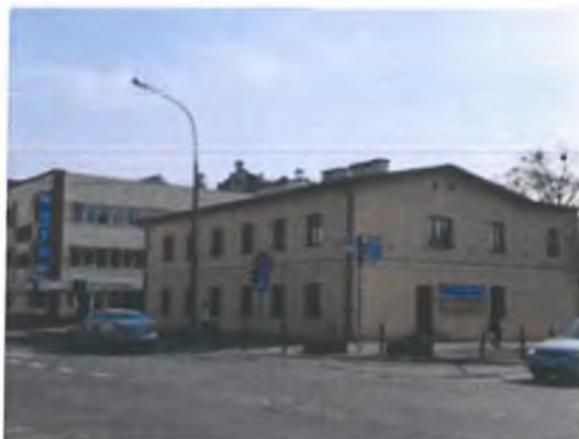
Zdjęcie 14. Rodzaj wykończenia obiektu – tynk, obiekt zabytkowy, budynek przy ul. 1 Maja 43b
