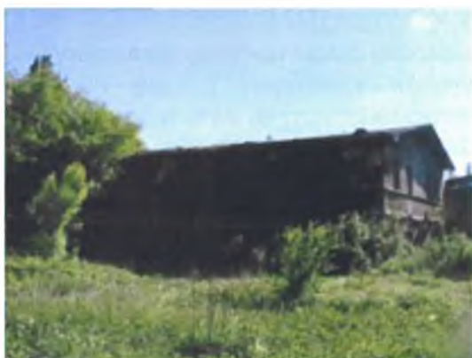
Zdjęcie 54. Obiekt w stanie katastrofalnym przy ul. 1 Maja 68
