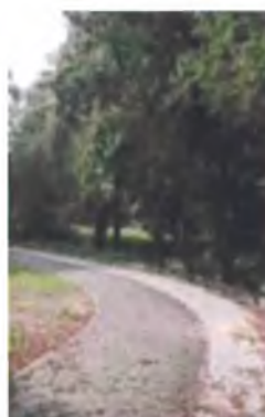
Zdjęcie 28. Nowa nawierzchnia ścieżki rowerowej i chodnika – stan dobry
