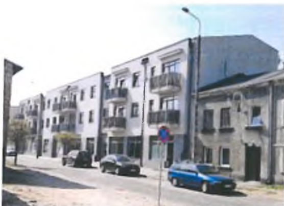
Zdjęcie 15. Rodzaj wykończenia obiektu współczesnego – tynk, budynek przy ul. Kilińskiego 46
