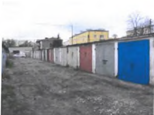
Zdjęcie 7. Obiekty garażowe zlokalizowane przy ul. Spokojnej 40.
