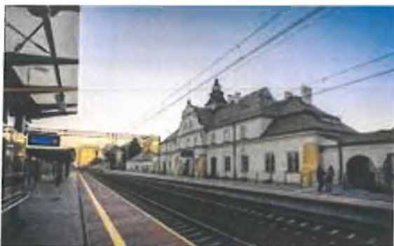
Zdjęcie 34. Widok z peronu na Dworzec PKP
