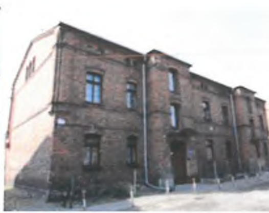
Zdjęcie 59. Budynek o średnim stanie technicznym fundamentów przy ul. Narutowicza 34.
