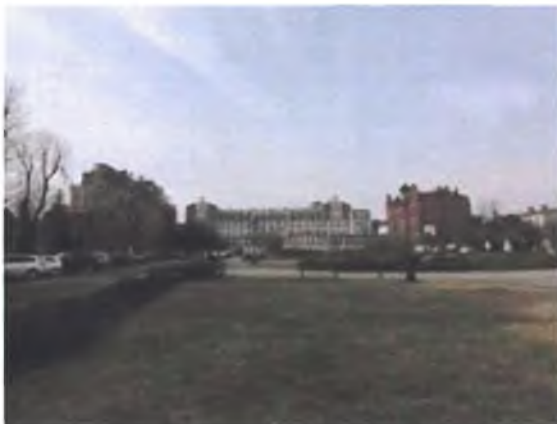
Zdjęcie 89. Widok na budynki fabryczne – dominanty przestrzenne: Starą Przędzalnię (budynek na wprost) oraz Nową Przędzalnię (budynek po lewej stronie)
