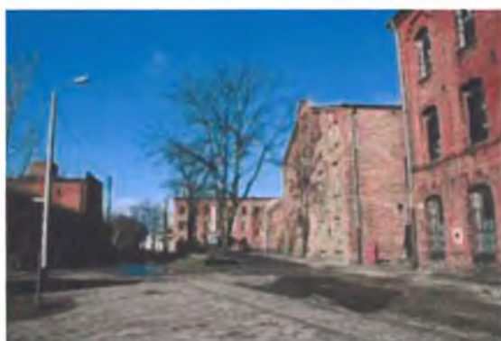
Zdjęcie 17. Droga z płyt betonowych na terenie Bielnika Źródło: Opracowanie własne, grudzień 2018
