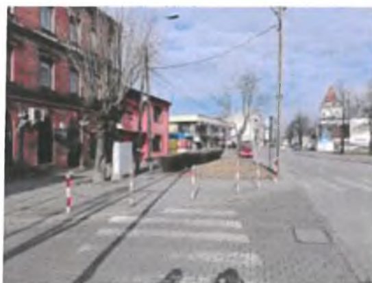
Zdjęcie 110. Zmodernizowana ulica POW
