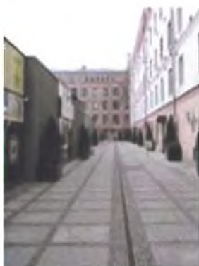
Zdjęcie 26. Nawierzchnia mieszana z kostek granitowych i płyt betonowych – stan dobry
