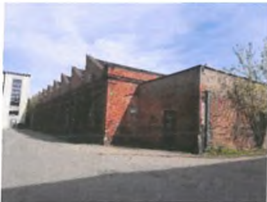
Zdjęcie 37. Średni stan elewacji – budynek przy ul. Lniarskiej 4.
