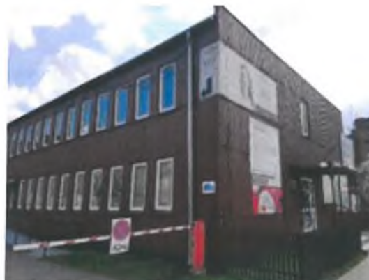
Zdjęcie 18. Rodzaj wykończenia obiektu – inny, budynek przy ul. Limanowskiego 49b
