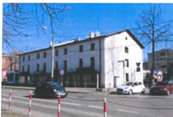
Zdjęcie 44. Budynek o dobrym stanie technicznym dachu przy ul. 1 Maja 48.
