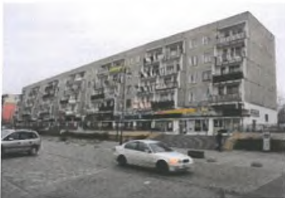
Zdjęcie 23. Zabudowa o 5 kondygnacjach przy ul. Okrzei 8/14
