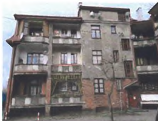
Zdjęcie 51. Budynek z zaburzonymi pierwotnymi wymiarami, wykonany z różnych materiałów przy ul. 1 Maja 59
