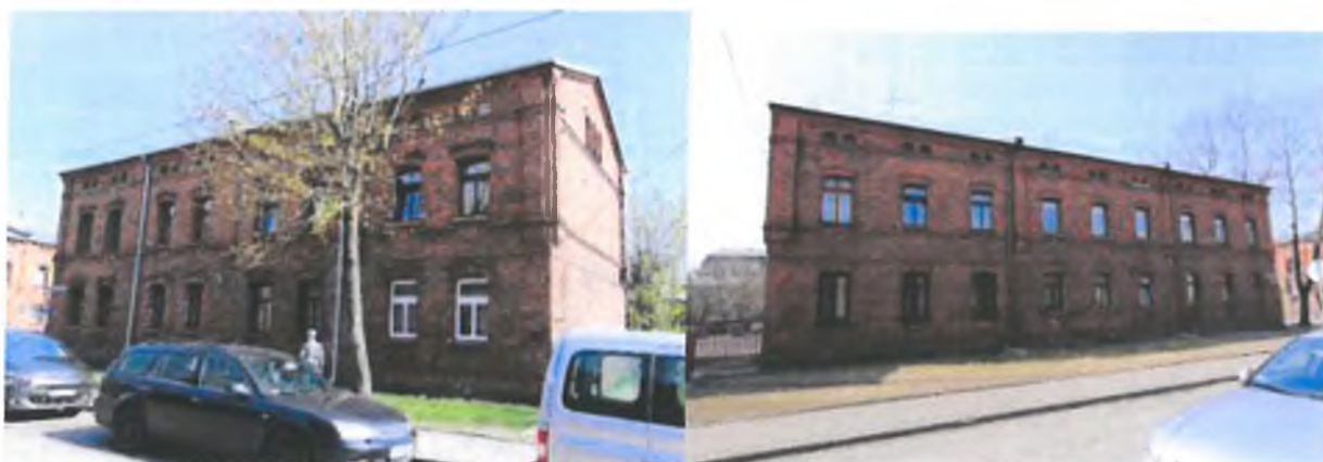
Zdjęcie 64. Przykłady budynków, w których stan zachowania historycznej stolarki okiennej został określony jako zły lub bardzo zły
