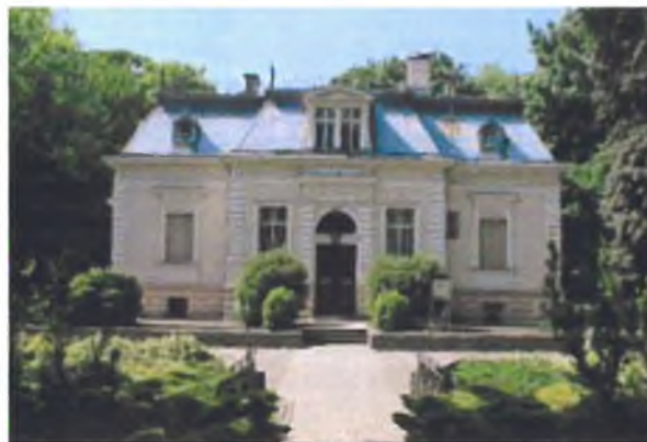
Zdjęcie 49. Budynek o dobrym stanie technicznym stolarki okiennej i drzwiowej przy ul. Dittricha 1.
