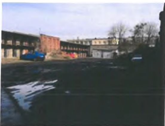
Zdjęcie 77. Zdegradowane podwórko osady pofabrycznej
