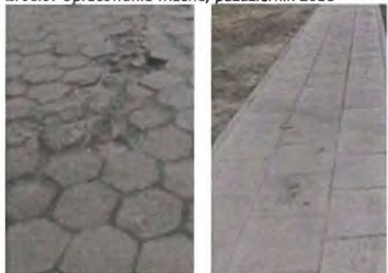
Zdjęcie 24. Nawierzchnia z płyt betonowych Źródło: Opracowanie własne, październik 2018
