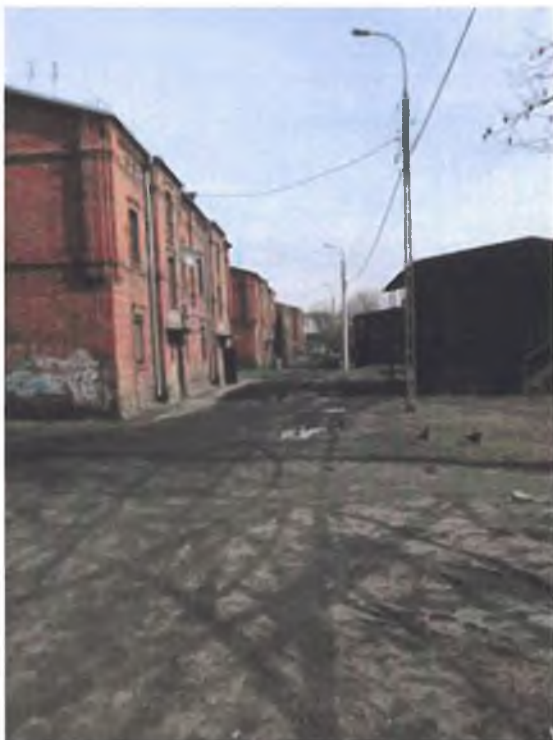
Zdjęcie 103. Podwórko w osadzie pofabrycznej
