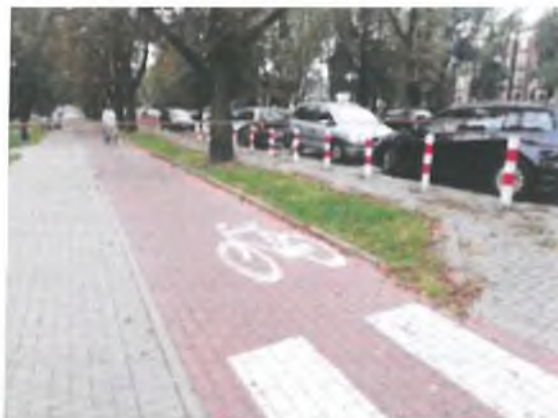
Zdjęcie 39. Parkingi równoległe przy alei Partyzantów
