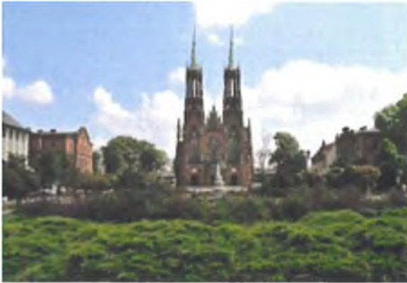
Zdjęcie 25. Budynek o nietypowej wysokości kondygnacji – Kościół pw. Matki Bożej Pocieszenia przy ul. Wyszyńskiego 5.
